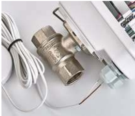
Фото 8. Завести провод датчика в кабельный ввод
